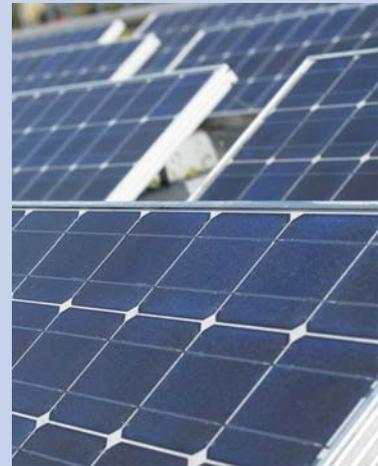
**Zur Orientierung:** Eine handelsübliche 3 kW Anlage von ca. 30 m<sup>2</sup> Fläche erwirtschaftet pro Jahr ca. 3.000 kWh. Je nach Haushaltsgröße kann also der private Energiebedarf zum Großteil selbst gedeckt werden. Die im EEG (Erneuerbare-Energien-Gesetz) geregelte attraktive Einspeisevergütung garantiert für 20 Jahre Kapitalrücklauf und feste, lukrative Vergütungssätze. **Sonnige Aussichten!**
